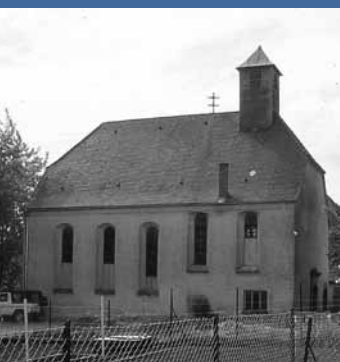
Ehemalige Synagoge Oberdorf 1988
