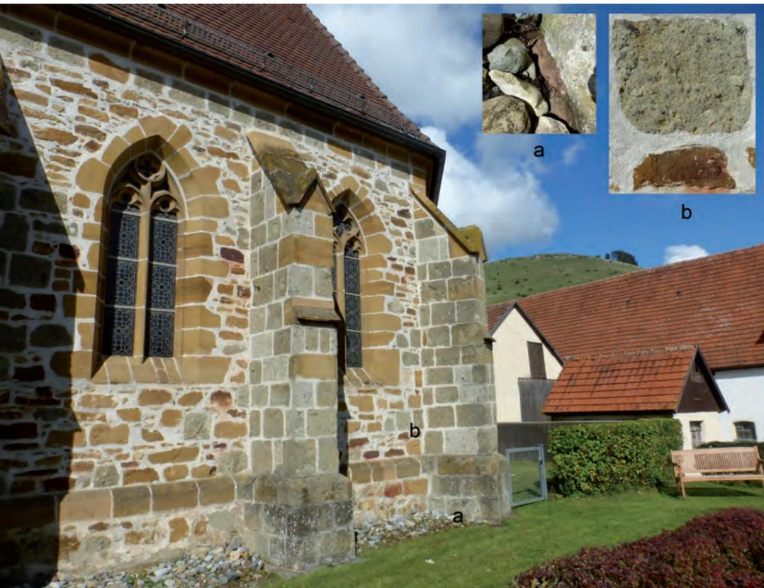
Abb. 4: Ältester Teil der evangelischen St. Georgskirche. Die Fundamente (a) sind teilweise aus massiven Eisensandsteinblöcken gefertigt. Das Mauerwerk ist überwiegend aus beim Riesimpakt entstandenen Suevit (b – oben), daneben aus zahlreichen weiteren Gesteinen wie Eisensandstein (b- unten) und Westhausener Sandstein aufgebaut.
